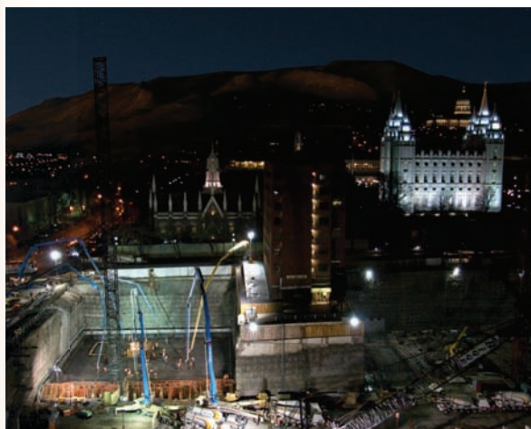
City Creek Center Concrete Pour
